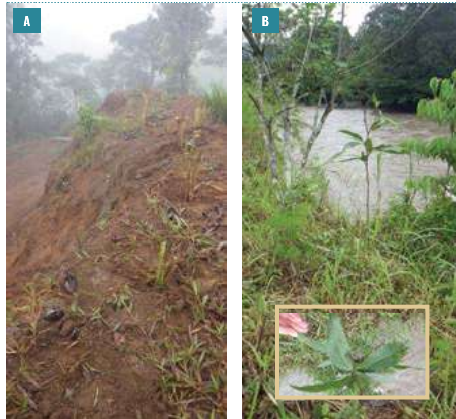
Figura 2. A. Siembra de vetiver ( Chrysopogon zizanioides ). Sistema recién implementado para proteger la pendiente y evitar la erosión del suelo. B. Siembra de chíparos ( Zygia longifolia ) en la ribera del río Guayllabamba. Para protección de borde de río y evitar erosión. Las raíces profundas de ambas especies sujetan el suelo, evitando la erosión por falta de cubierta vegetal.
